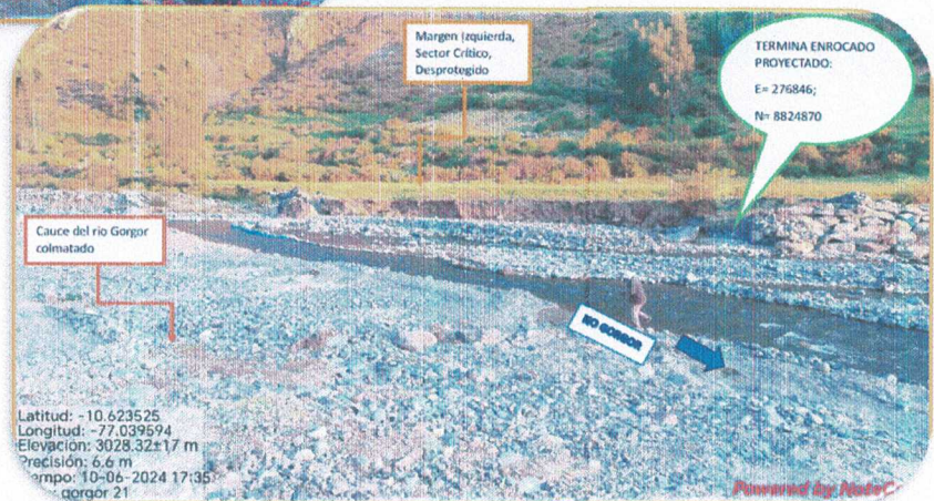
FIGURA N°01: SE OBSERVA EL INICIO Y FINAL DEL TRAMO CRITICO A CONSTRUIR DEFENSA RIBEREÑA MAGEN IZQUIERDA DEL SECTOR PUEBLO GORGOR, DISTRITO DE GORGOR, PROVINCIA DE CAJATAMBO - REGIÓN LIMA; ADEMÁS NECESITA LIMPIEZA Y DESCOLMATACIÓN DE CAUCE DEL RIO GORGOR.
